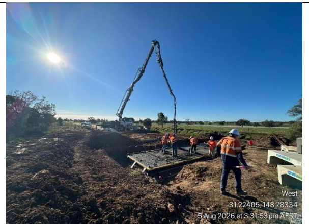
Pour of Box Culvert DT34
