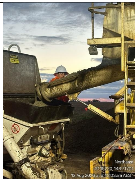
Pour of Box Culvert DT17
