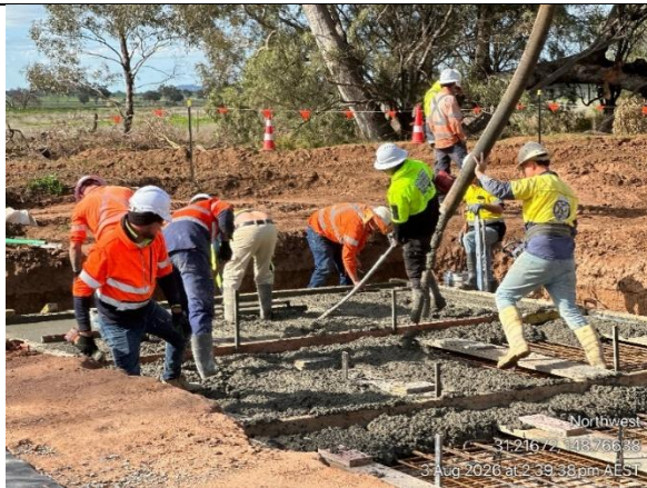
Pour of Box Culvert DT30
