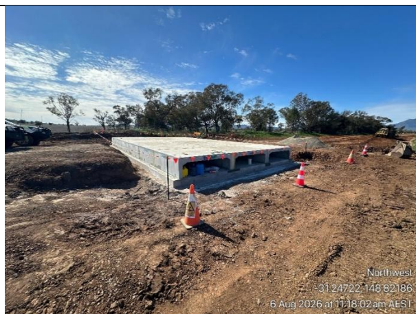
Pour of Box Culvert DT30
